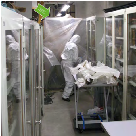
Abbildung 7: Improvisierte Reinigungskabine mit Luftabsaugung (grüner Pfeil) durch Spezialfiltermatte (HEPA). Die Einrichtung ist mitten in einem von Schimmel befallenen Museumsdepot aufgebaut.
